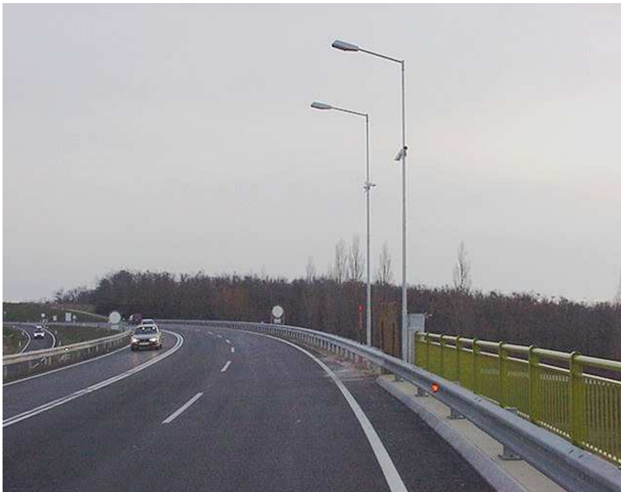
Bild 3: Beispiel einer WIV On-site Station
